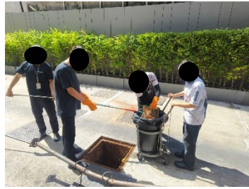
ตัดไขมันจากระบบระบายน้ำเสีย
