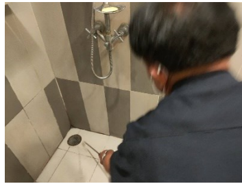
ตัดไขมันจากระบบระบายน้ำเสีย
